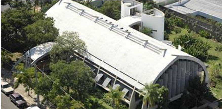
Figura 69: Vista aérea do Centro Sebrae de Sustentabilidade
