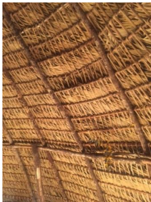
Figura 16: Detalhe da trama do fechamento da háti
