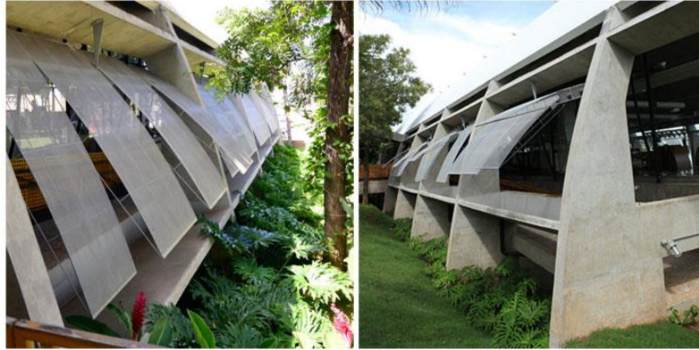
Figura 72: Detalhe dos brises manuais das janelas do edifício
