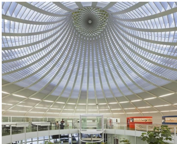
Figura 65: Detalhe cobertura que proporciona iluminação natural
