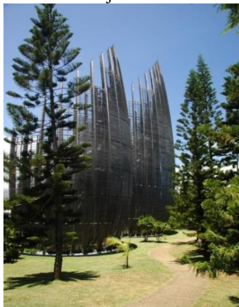
Figura 51: Acesso ao Centro Cultural Jean-Marie Tijibaou
