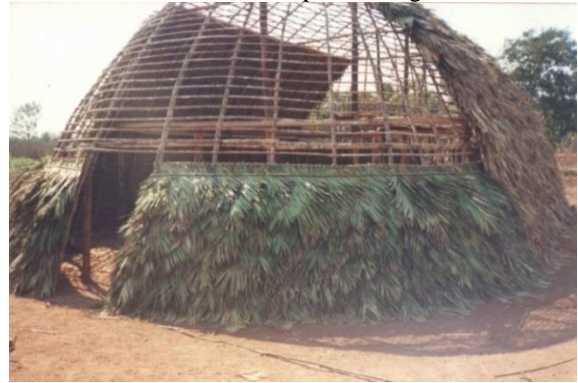
Figura 15: Fechamento da háti com caibros de madeira e molhos de palhas de guariroba
