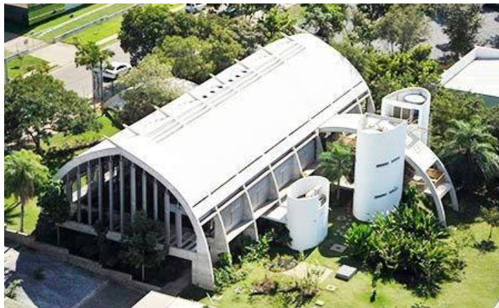
Figura 68: Vista aérea do Centro Sebrae de Sustentabilidade
