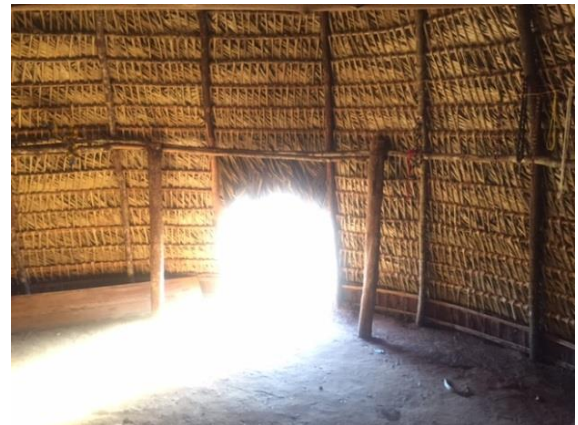
Figura 17: Detalhe da porta de acesso á háti
