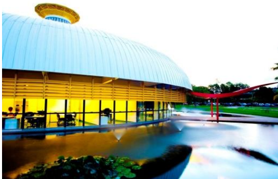
Figura 60: Detalhe espelho d'água circundante ao edifício
