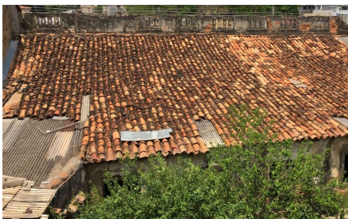
Figura 49: Vista interna da edificação. Fonte: Próprio Autor, 2017.
