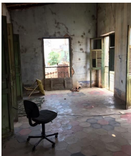
Figura 34: Vista interna do Nível II. Fonte: Próprio Autor, 2017.
