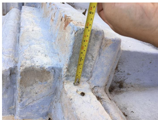
Figura 20: Levantamento in loco – Fachada Rua Ricardo Franco. Fonte: Próprio Autor, 2017.
