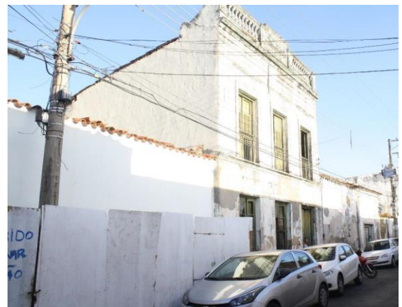
Figura 12: Fachada da Rua Engenheiro Ricardo Franco. Fonte: Próprio Autor, 2017.
