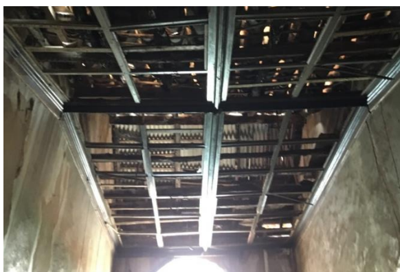
Figura 15: Forro de um dos ambientes do imóvel. Fonte: Próprio Autor, 2017.
