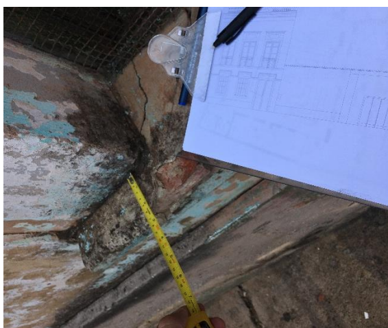
Figura 19: Levantamento in loco – Fachada Rua Sete de Setembro. Fonte: Próprio Autor, 2017.
