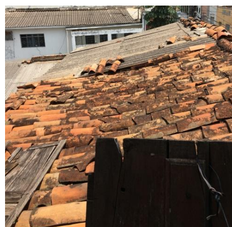
Figura 50: Cobertura do Nível I. Fonte: Próprio Autor, 2017.
