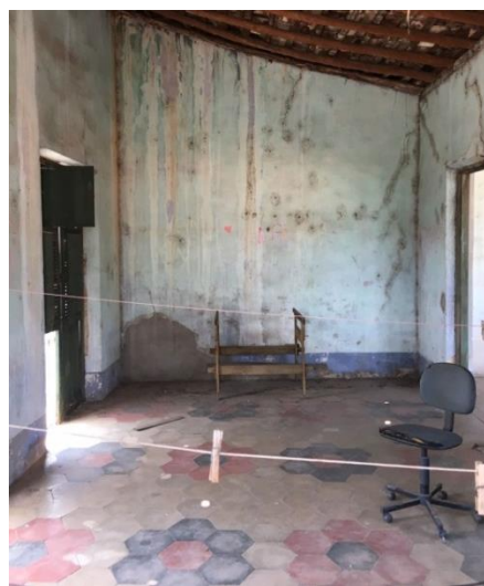
Figura 35: Vista interna do Nível II. Fonte: Próprio Autor, 2017.
