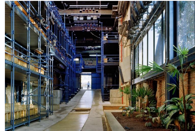
Figura 43 – Passarela no centro do Teatro Oficina
