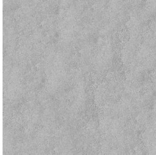
Figura 127 - Piso em concreto
