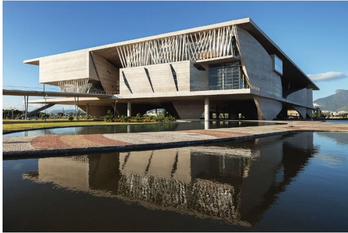
Figura 62 - Uma das fachadas do edifício
