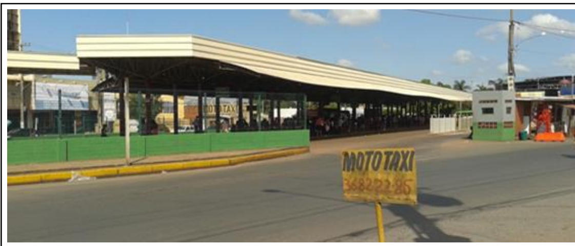
Figura 5 - Terminal André Maggi no centro do perímetro urbano.
