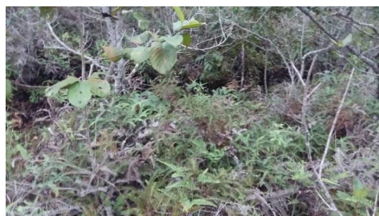
Figura 07 – Vegetação e inclinação de talude da M8D.
