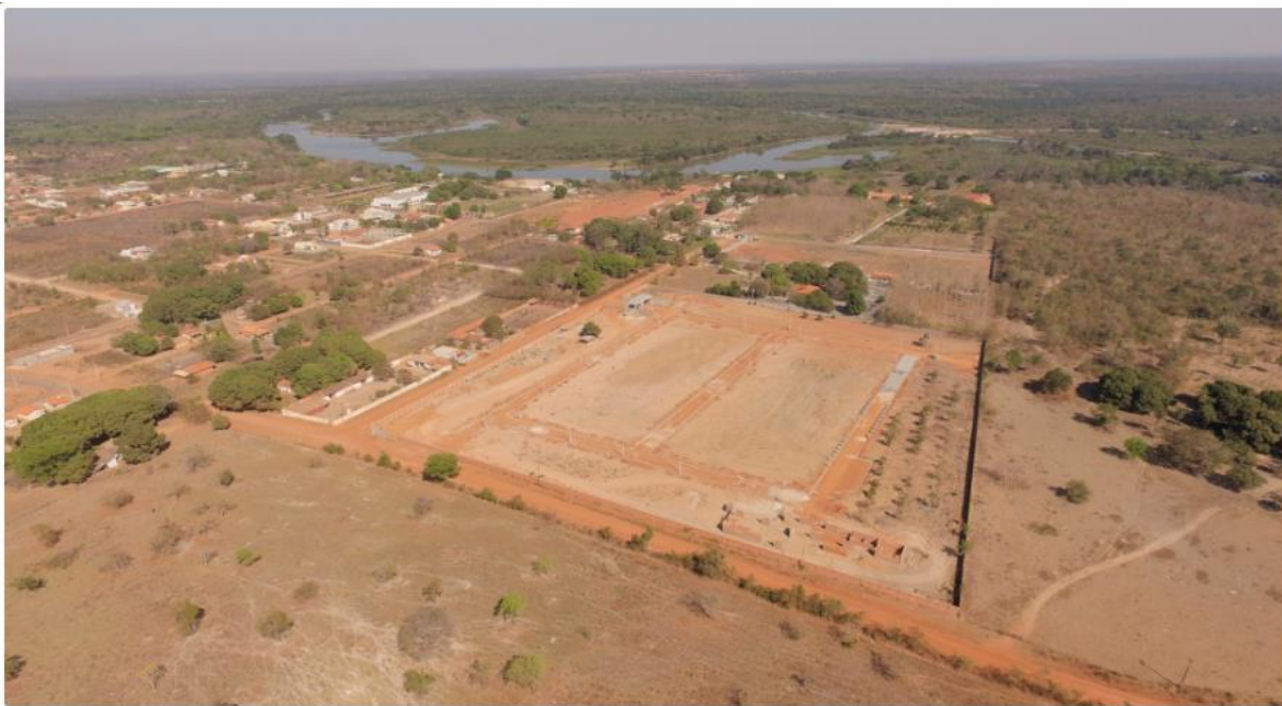
Figura 26. Vista aérea do condomínio Solare.
