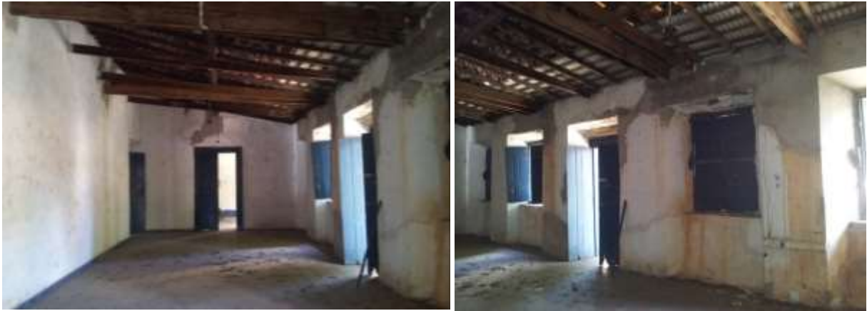
Figura 84 e 85 – Interior do casarão de Bem Bem. Fonte: Arquivo IPHAN/MT, 2012.
