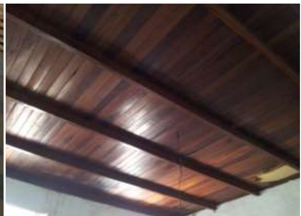
Figura 87 – Forro de madeira em bom estado de conservação. Fonte: Arquivo IPHAN/MT, 2012.
