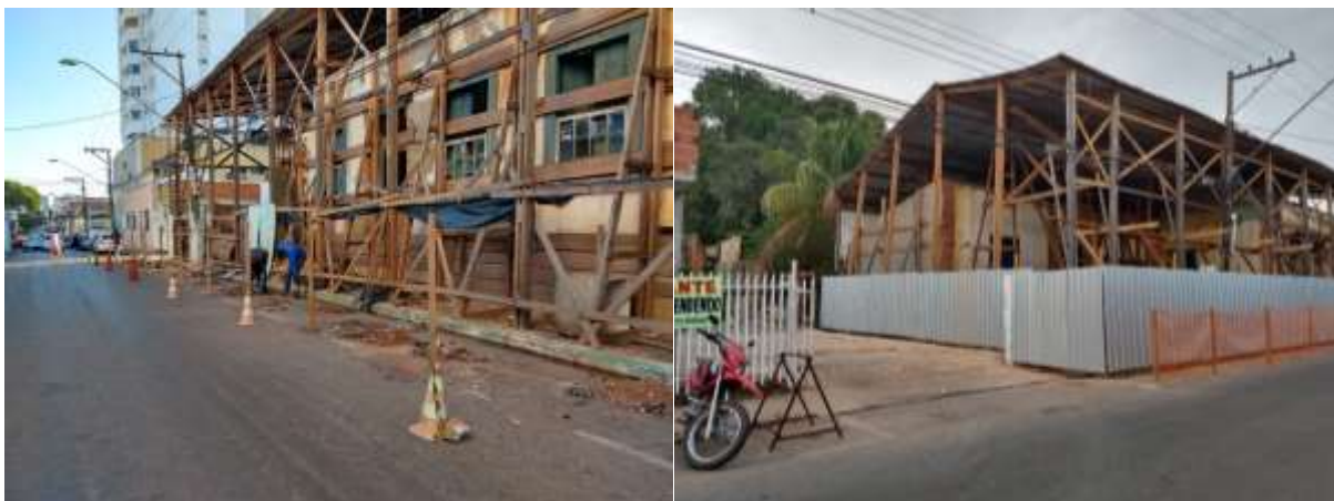
Figura 102 e 103 – Construção da sobrecobertura.
