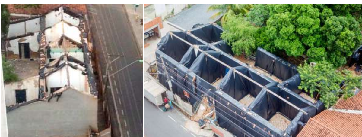
Figura 98 e 99 – Obras da Casa de Bem Bem. Fonte: Alair Ribeiro, 2017.
