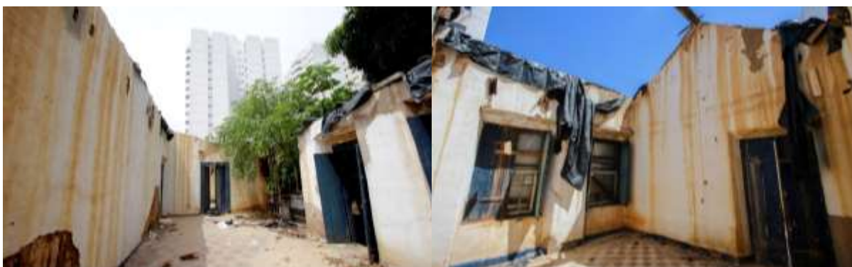
Figura 96 e 97 – Obras da Casa de Bem Bem. Fonte: Alair Ribeiro, 2017.
