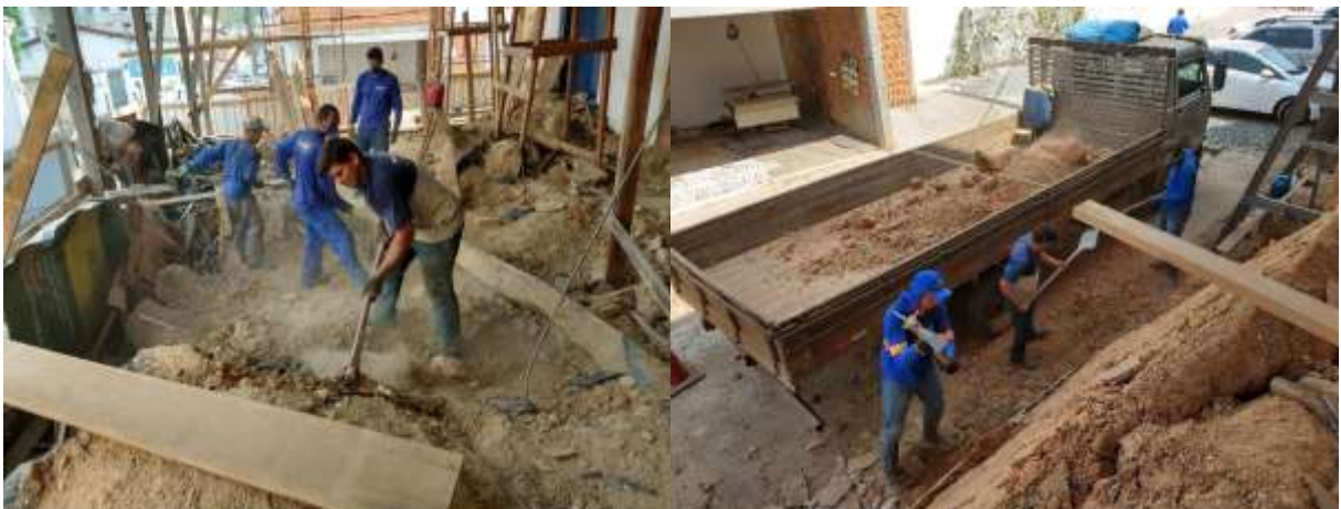
Figura 109 e 110 – Recolhimento da taipa e adobe das paredes ruídas. Fonte: Achaíos, 2019.
