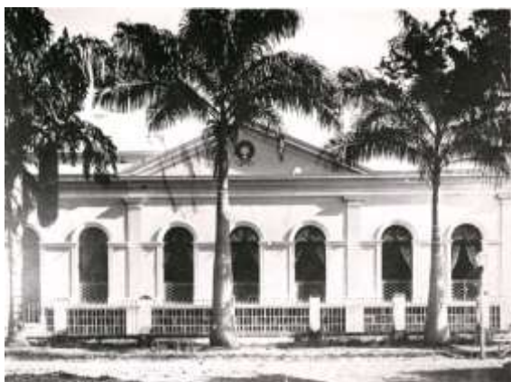
Figura 11 – Antigo Palácio Alencastro Fonte: Banco de imagens do IPHAN/RJ
