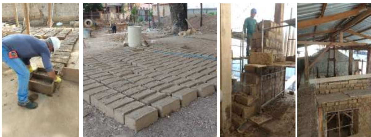
Figura 136, 137, 138 e 139 – Fabricação e construção das paredes de adobe. Fonte: Própria, 2021.
