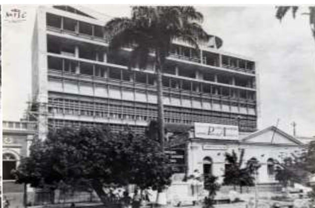
Figura 12 – Construção do novo Palácio Alencastro Fonte: Banco de imagens do MISC
