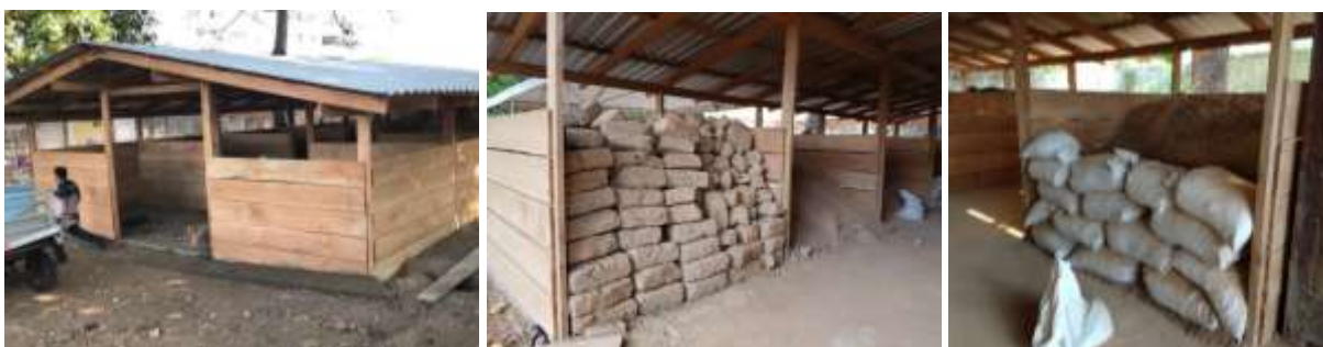
Figura 111, 112 e 113 – Galpão de armazenamento de material. Fonte: Própria, 2019.
