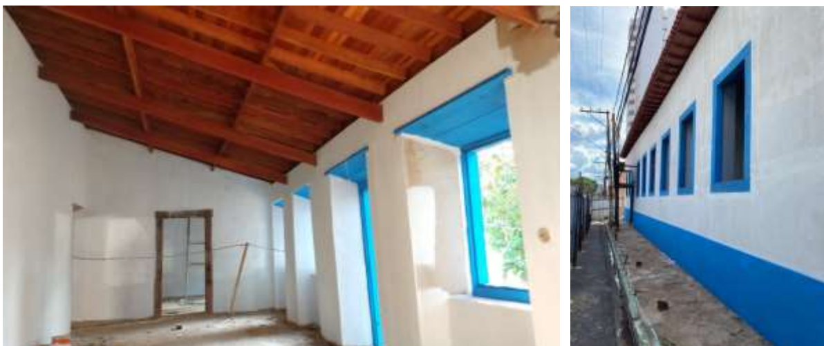
Figura 146 e 147 – Primeira demão de tinta nas paredes e esquadrias.
