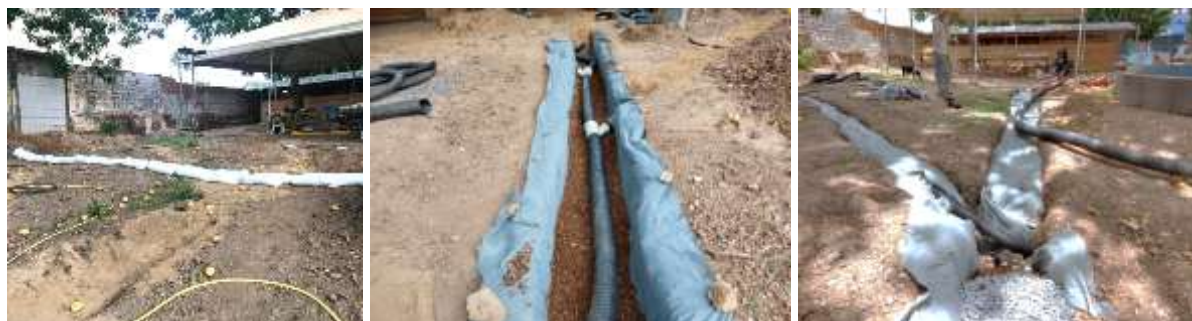
Figura 114, 115 e 116 – Etapas de drenagem do solo. Fonte: Própria, 2019.
