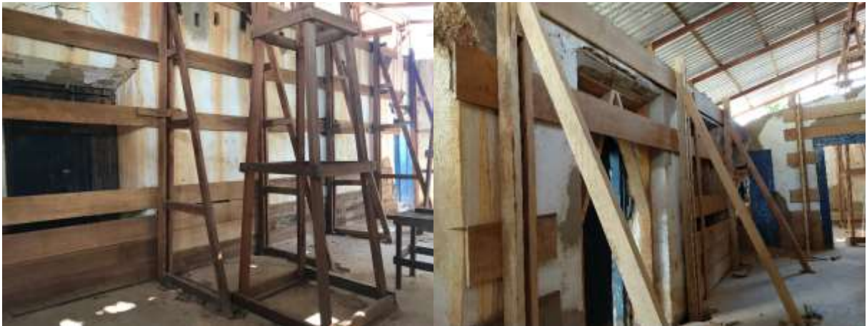
Figura 107 e 108 – Construção da sobrecobertura. Fonte: Achaíos, 2019.
