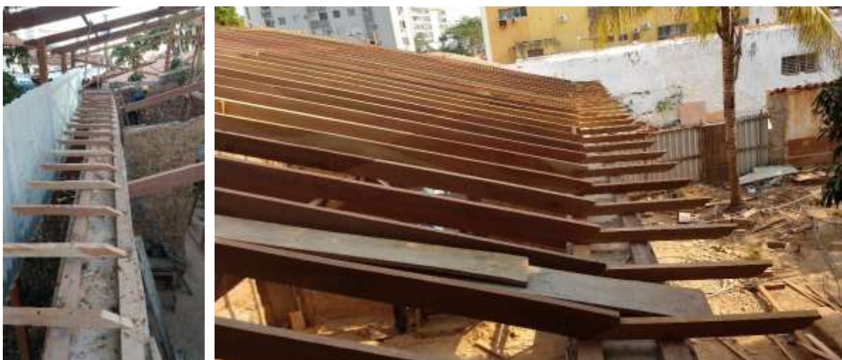
Figura 140 e 141 – Instalação do madeiramento da cobertura. Fonte: Própria, 2021.
