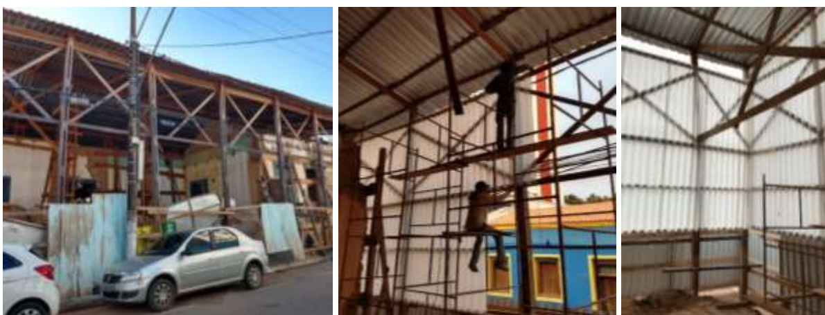
Figura 104 e 105 – Construção da sobrecobertura.
