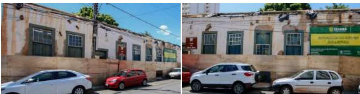
Figura 94 e 95 – Obras da Casa de Bem Bem. Fonte: Alair Ribeiro, 2017.
