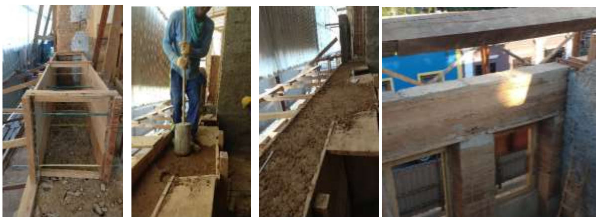
Figura 132, 133, 134 e 135 – Fabricação e construção das paredes de taipa. Fonte: Própria, 2021.
