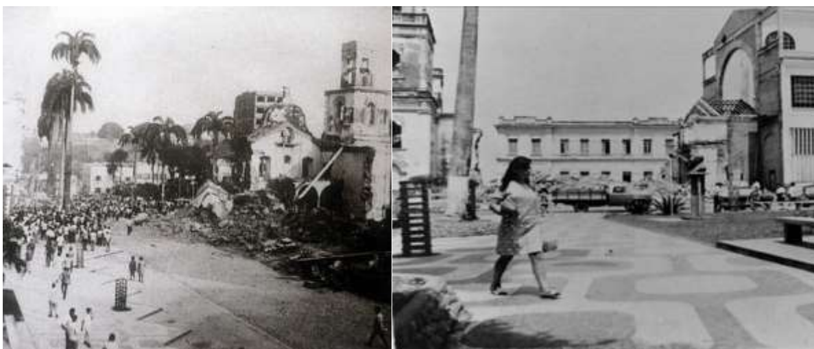
Figuras 16 e 17 – Demolição da Catedral do Senhor Bom Jesus de Cuiabá, 1968. Fonte: Acervo Público de Mato Grosso.
