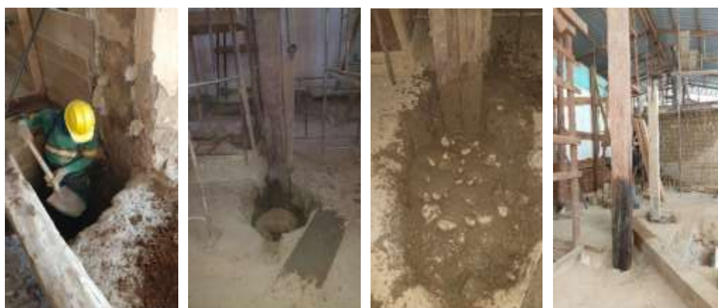
Figura 128, 129, 130 e 131 – Substituição dos esteios em madeira danificados. Fonte: Própria, 2021.
