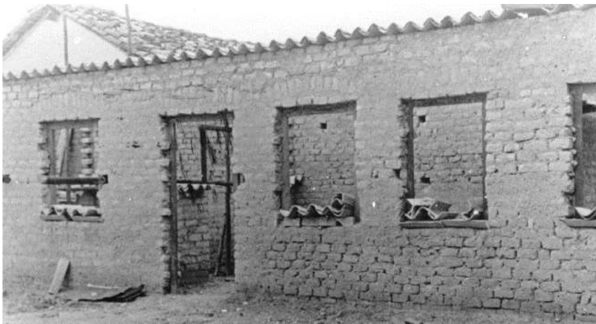
Figura 62 – Construção em adobe. Fonte: Banco de imagens do IPHAN/RJ.
