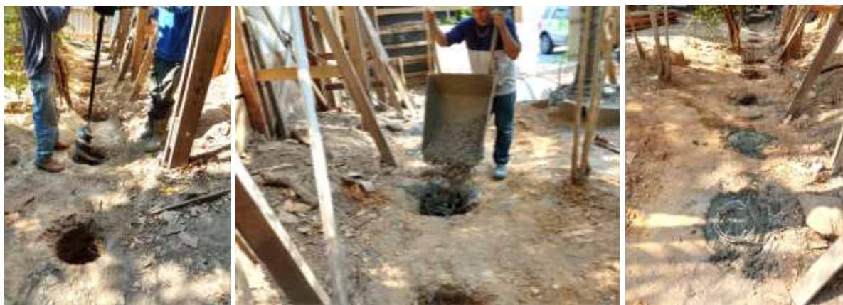
Figura 117, 118 e 119 – Construção da cortina de concreto. Fonte: Própria, 2019.
