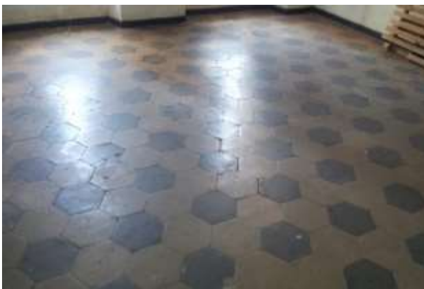
Figura 86 – Pisos em ladrilho hidráulico em bom estado de conservação. Fonte: Arquivo IPHAN/MT, 2012.
