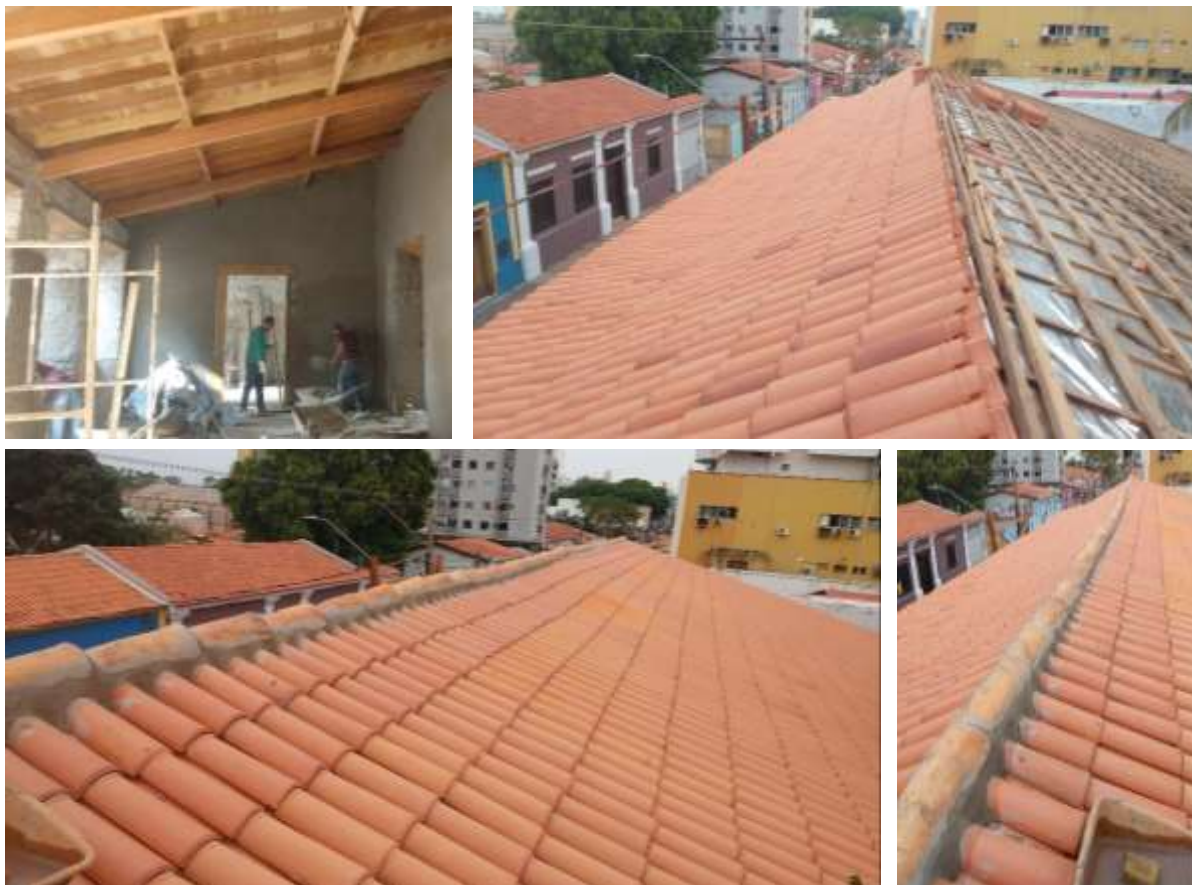
Figura 142, 143, 144 e 145 – Instalação do forro em madeira e telhas cerâmicas coloniais. Fonte: Própria, 2021.
