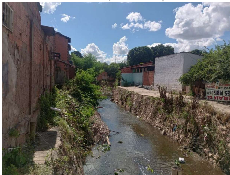
Figura 5.5 - Córrego do Gambá com resíduos sólidos e esgoto das casas do entorno - Rua Padre Gerônimo Botelho, 182 – Dom Aquino – Cuiabá
