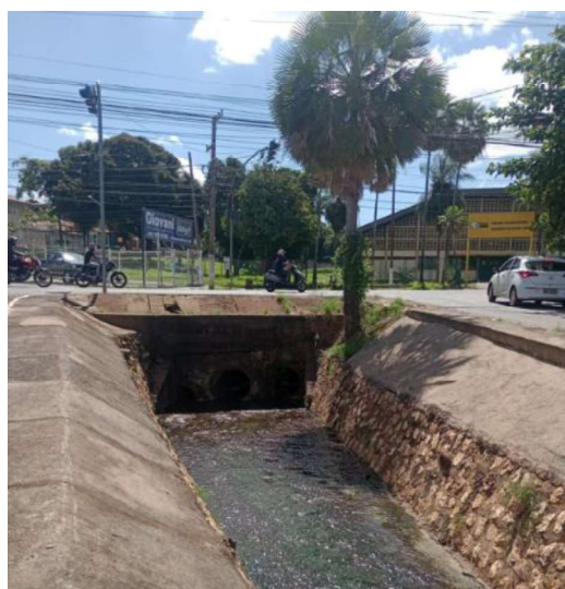
Figura 4.7 - Córrego do Gambá canalizado - Rua João Gomes Monteiro Sobrinho - Areão – Cuiabá
