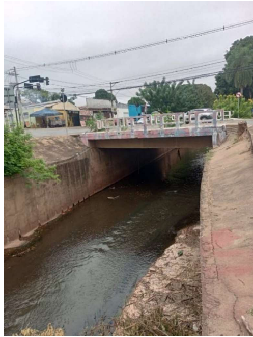
Figura 4.49 - Ponte sobre o Córrego Barbado, entorno com diversas residências e comércio – Av. Tancredo Neves, 1390 – Barbado – Cuiabá
