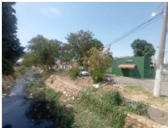
Figura 4.15 - Córrego Gambá com residências e diversos comércios - Rua Pres. Leite Figueiredo, 520 – Terceiro – Cuiabá
