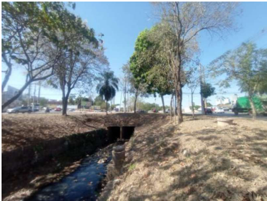
Figura 4.40 - Entorno do córrego com vias públicas e pouca presença de cobertura vegetal – Rua Boa Esperança, Av. Das Torres, 312 – Bosque da Saúde – Cuiabá
