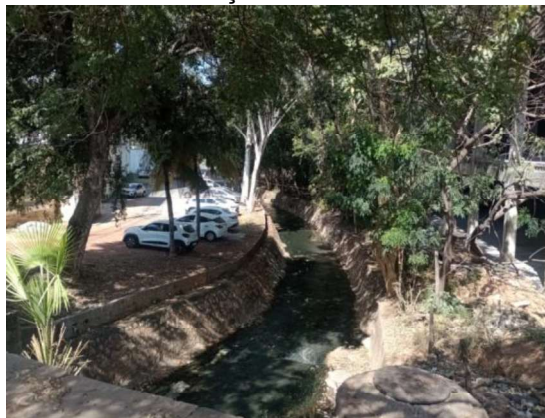
Figura 4.19 - Córrego do Gambá, impermeabilizado com pouca cobertura vegetal – Av. Fernando Correa da Costa, 216 - Poção – Cuiabá
