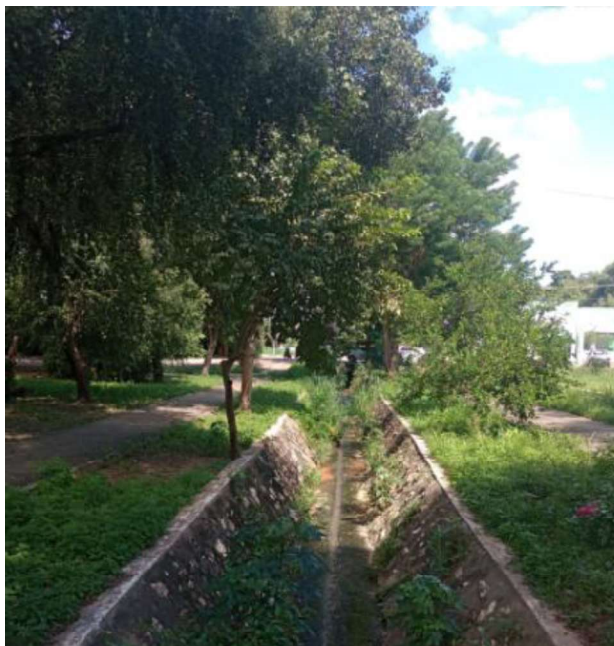
Figura 5.3 - Canalização do Córrego Gambá - Rua Coronel Carciolo de Melo, 216 - Lixeira – Cuiabá
