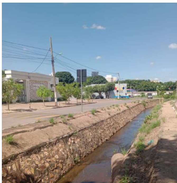
Figura 5.4 - Córrego do Gambá canalizado - Rua Antônio Batista Belém, 526 - Areão – Cuiabá
