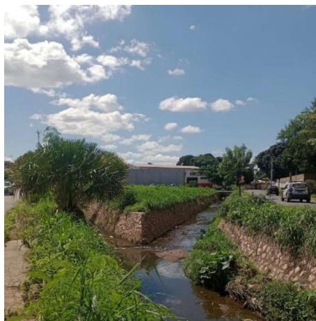
Figura 4.8 - Córrego do Gambá – Travessa Dois, 162 - Areão – Cuiabá
