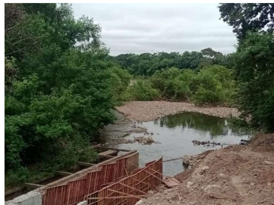
Figura 4.25 - Comércio no entorno do Córrego do Gambá (Não respeitando os limites da APPs) – Av. Beira Rio Sul, 4048 - Terceiro – Cuiabá
