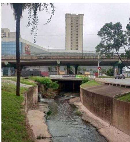
Figura 4.46 - Córrego Barbado (próximo ao Shopping 3 Américas, onde há incidência de alagamento) – Av. Tancredo Neves, 56 – Jd. Petrópolis – Cuiabá
