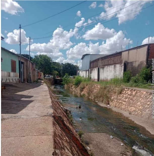
Figura 4.22 - Córrego do Gambá, recebendo esgotos e resíduos sólidos das residências do entorno – Av. Manoel José de Arruda, 225 - São Mateus – Cuiabá
