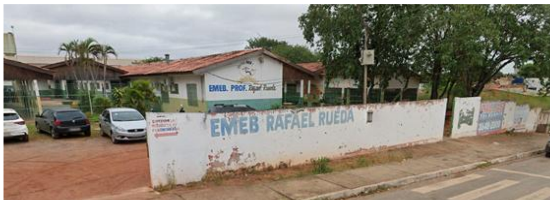
Figura 28 - Escola de Ensino Fundamental Rafael Rueda no entorno do Residencial Nova Canaã
