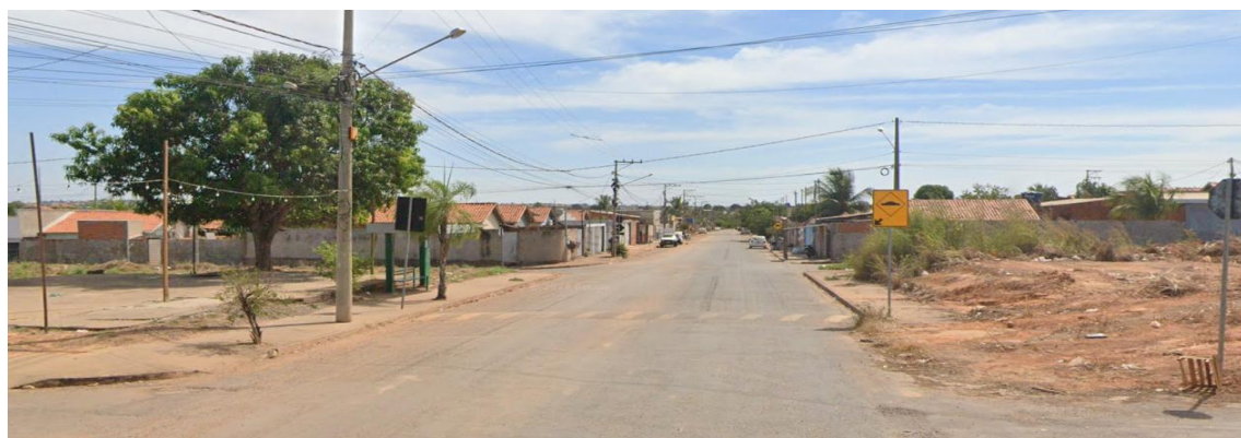
Figura 39 - Ponto de ônibus, ao lado esquerdo com abrigo e no lado direito apenas placa de ônibus na Avenida A do Residencial Nova Canaã
