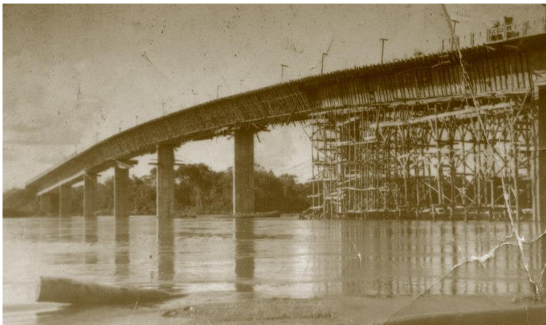
Figura 8 - Construção da ponte Marechal Rondon
