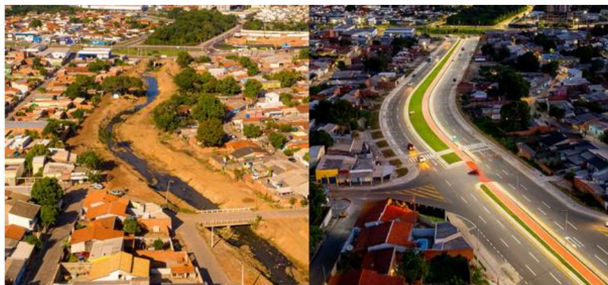
Figura 31 – Avenida Parque – Córrego do Barbado no processo de limpeza das margens para obra de pavimentação e obra concluída em 2020.
