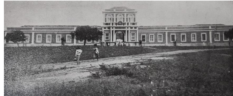
Figura 11 – Arsenal de Guerra localizado próximo ao porto de Cuiabá, com o largo na frente do edifício militar.
