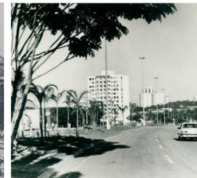
Figura 23 – Avenida do CPA implantada.
