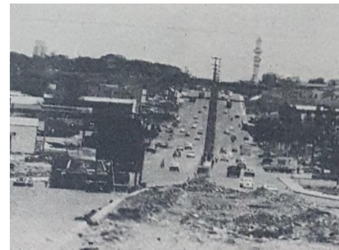
Figura 22 – Pavimentação da Avenida Fernando Correa da Costa.
