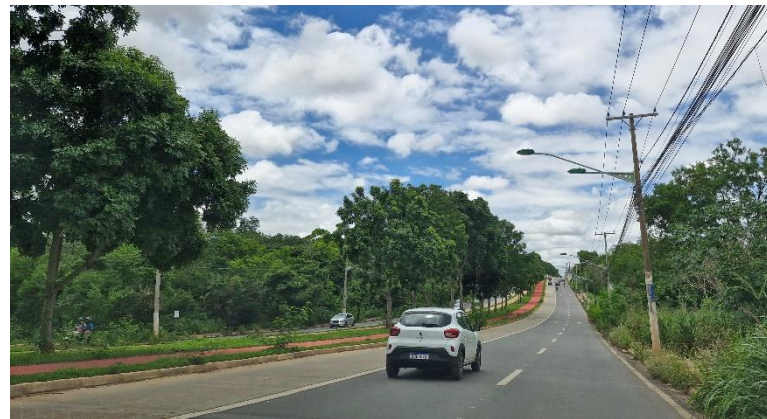
Figura 68 - Ciclovia junto a infraestrutura do BRT em parte da Avenida do CPA.
