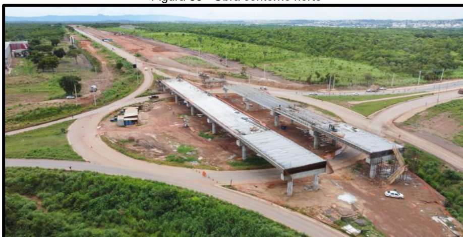
Figura 33 - Obra contorno norte
