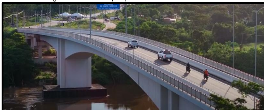
Figura 32 - Vista em perspectiva da Ponte Sarita Baracat
